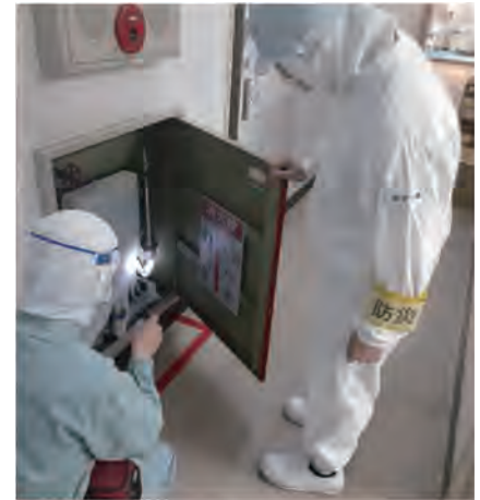
消火設備点検の様子
