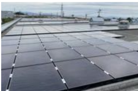
太陽光パネルを設置した様子
