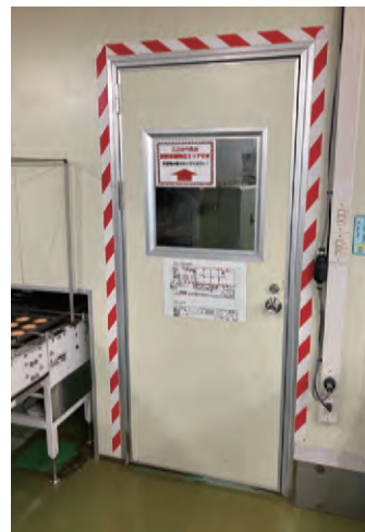
▲燃焼設備エリア入口の表示
