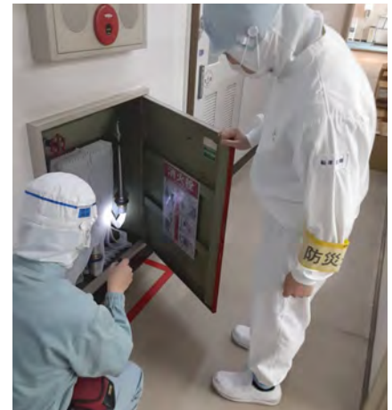
消火設備点検の様子
